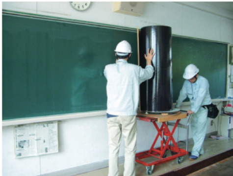
ピタマグロール貼替工法
